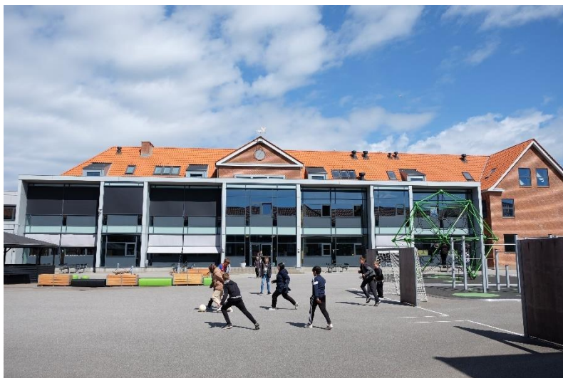
Parti fra Skolevej 2, hvor det er tydeligt, at skolen er sammensat af bygningsafsnit af varierende alder og udseende.
